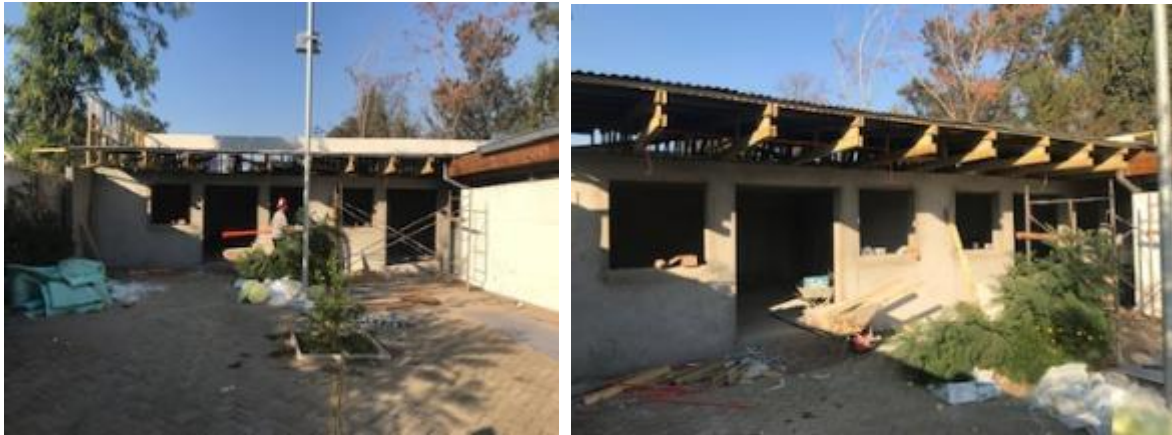
Fotografías Construcción Bodegas Municipales, Comuna de Pelarco 2020.
