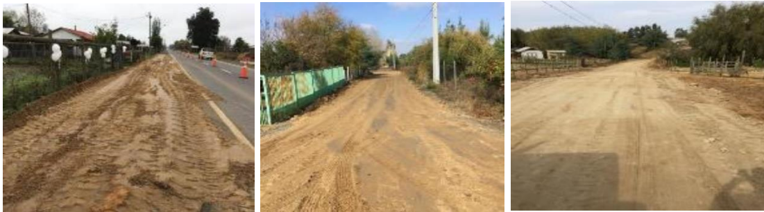
Fotografías Servicio de Instalación de Maicillo, Comuna de Pelarco 2020.
