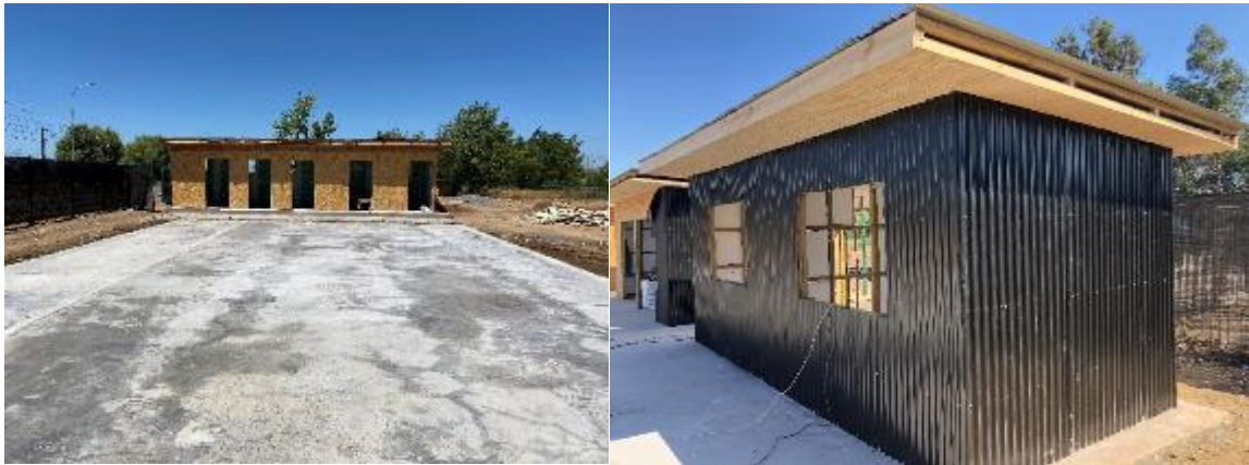
Fotografías Proyecto Construcción Mercadito 2020.
