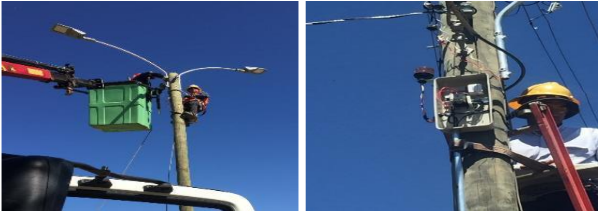
Fotografías Proyecto Instalación de Luminarias Publicas, Pelarco 2020.
