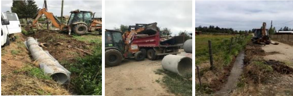
Fotografías Servicio de Retroexcavadora, Comuna de Pelarco 2020.
