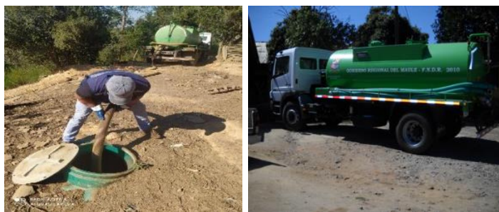
Fotografías Servicio de Camión Limpia Fosas 2020.
