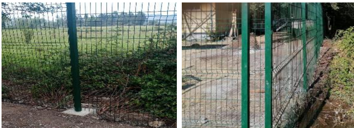
Fotografías Proyecto Cierre Perimetral Escuela Pablo Correa Montt 2020.
